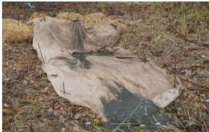
Obr. 1 Bariera a stoka plná zachyceného sedimentu – Novokoželský 2016 (vlevo), prostor před barierou vystlaný jutovou tkaninou pro zamezení podtékání – Pláňavy (vpravo)
