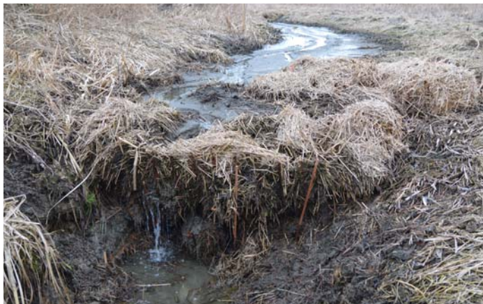
Obr. 1 Bariera a stoka plná zachyceného sedimentu – Novokoželský 2016 (vlevo), prostor před barierou vystlaný jutovou tkaninou pro zamezení podtékání – Pláňavy (vpravo)
