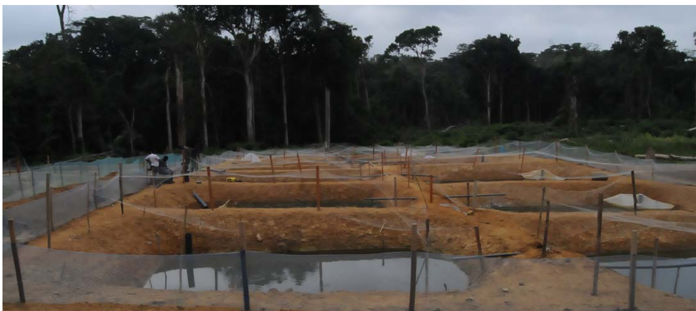
Nově vybudované odchovné rybníčky.
