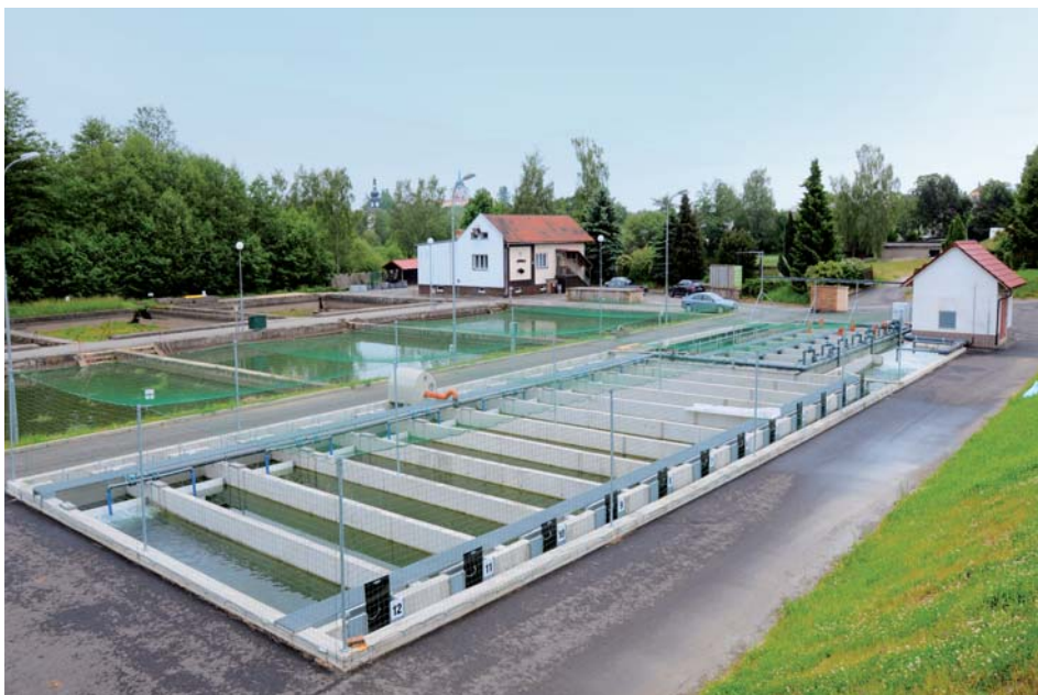
Recirkulační zařízení pro chov lososovitých ryb
