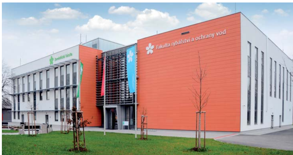
Ústav akvakultury a ochrany vod v Českých Budějovicích
