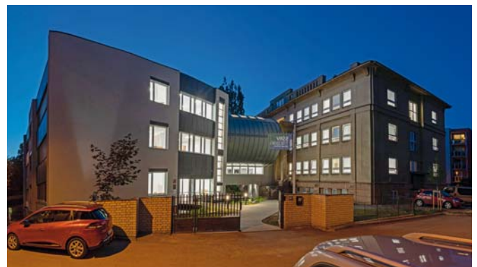
Celkový pohled na zmodernizovanou budovu
