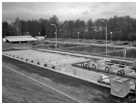
Obrázek 6: Nově vybudovaný RAS dánského typu pro chov sňhů a lososovitých ryb ve Žďáře n/Sázavou
