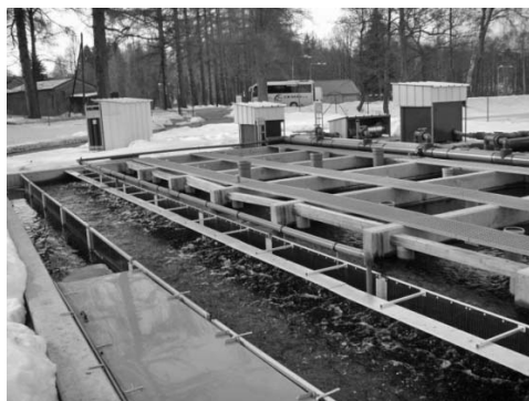
Obrázek 5: RAS dánského typu pro chov lososovitých ryb vPrávkově u Kamenice nad Lipou
